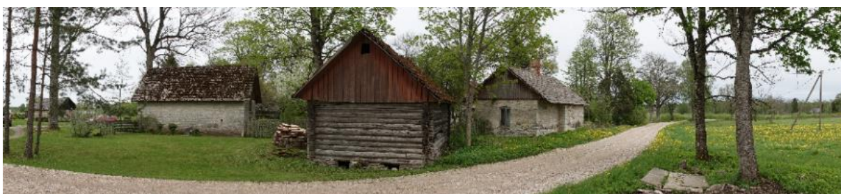
Joonis 12. Ahnevere-Mardi talumajapidamise kohalikust paekivist laotud abihooned Lipametsa küla miljööalal. Foto Cerly-Marko Järvela.
